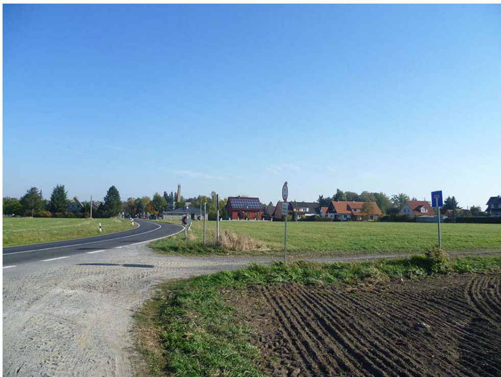
Einmündung des Erschließungsweges auf die Puschwitzer Straße / Blick nach Norden
