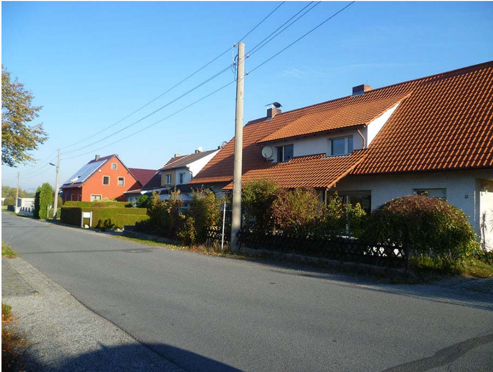
nördliche Bebauung der Siedlerstraße
